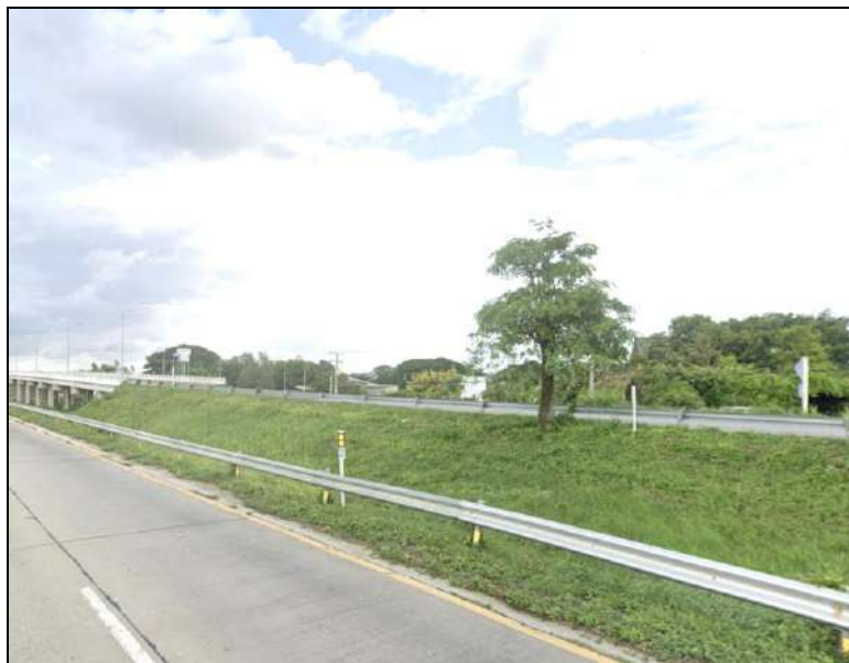
รูปที่ 5-4 สภาพพื้นที่บริเวณจุดเริ่มต้นโครงการ ทล.117 (กม.112+800)
