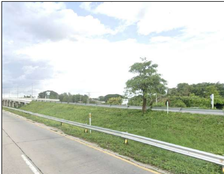
รูปที่ 6-4 สภาพพื้นที่บริเวณจุดเริ่มต้นโครงการ ทล.117 (กม.112+800)
