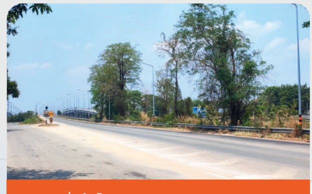
จุดเริ่มต้นโครงการ ทล.117 (กม.112+800)
